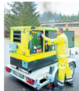
Blackout-Vorsorge: Ende 2021 schaffte der WAZV „Elbe-Elster-Jessen“ zwei Wasseranhänger und ein mobiles Notstromaggregat an. Die Kosten: Rund 75.000 Euro.
