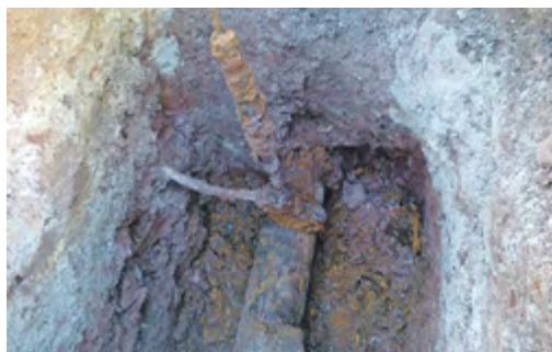
In die Jahre gekommene Trinkwasserleitungen wie diese werden ab diesem Jahr komplett erneuert.
