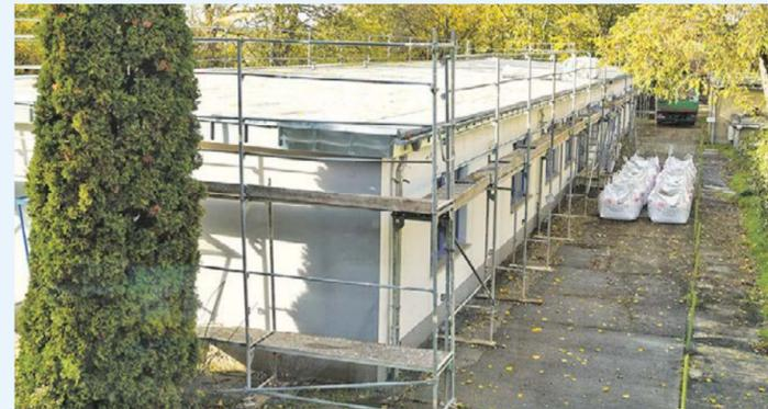
Dachsanierung: Die Dämmung und Abdichtung ist fertig. Die Kies-Lieferung steht schon bereit.
