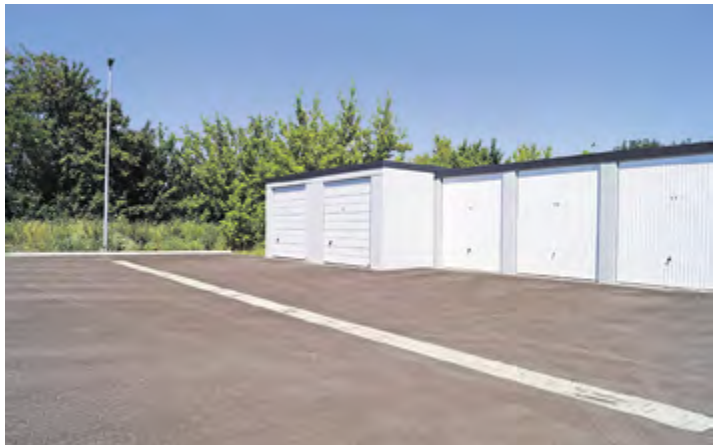
Nun ist der Vorplatz fertig saniert.
