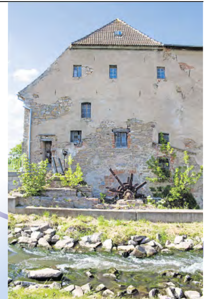
Das Wasserrad der Unteren Mühle in Güsten ist in seiner Grundstruktur erhalten und soll nach den Originalzeichnungen neu gebaut werden.
