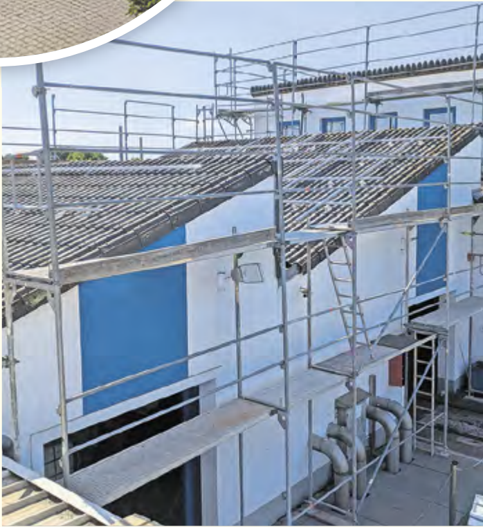
Nach und nach wurden alle Module für die PV-Anlage auf das Dach der Kläranlage Hecklingen montiert. Bereits Ende Juli waren die Arbeiten so weit vorangeschritten, dass der erste Strom floss. Dabei nutzte der Verband das bereits stehende Gerüst, um dem Kläranlagengebäude einen neuen Anstrich zu geben.
