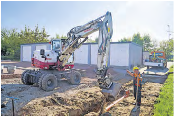
Die Bagger bewegten 53 Kubikmeter Schotter, bevor die Fläche vor den Garagen neu versiegelt wurde.
