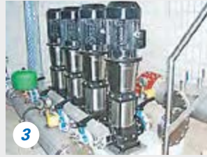
Gelungene Symbiose aus Natur und Technik – die Abläufe bei der Trinkwasserproduktion. 1 Regelmäßig entnehmen Mitarbeiter der TWM Wasserproben. 2 Immer genug Wasservorrat in riesigen Hochbehältern. 3 Futuristische Optik: Druckerhöhungsanlagen. 4 Grundwasser läuft bei seiner „Sauerstoffkur“ über Kaskaden – Eisen- und Manganablagerungen färben sie orangebraun.
