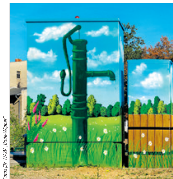
... nach dem Hauptpumpwerk an der Bode erstrahlt nun auch das Pumpwerk an der Post in neuem Glanz.
