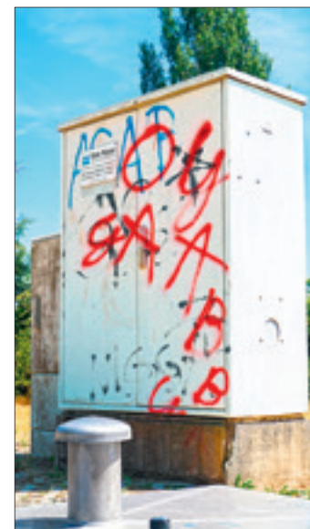
Beschmiert – so sah das Pumpwerk vor der Verschönerung aus.
