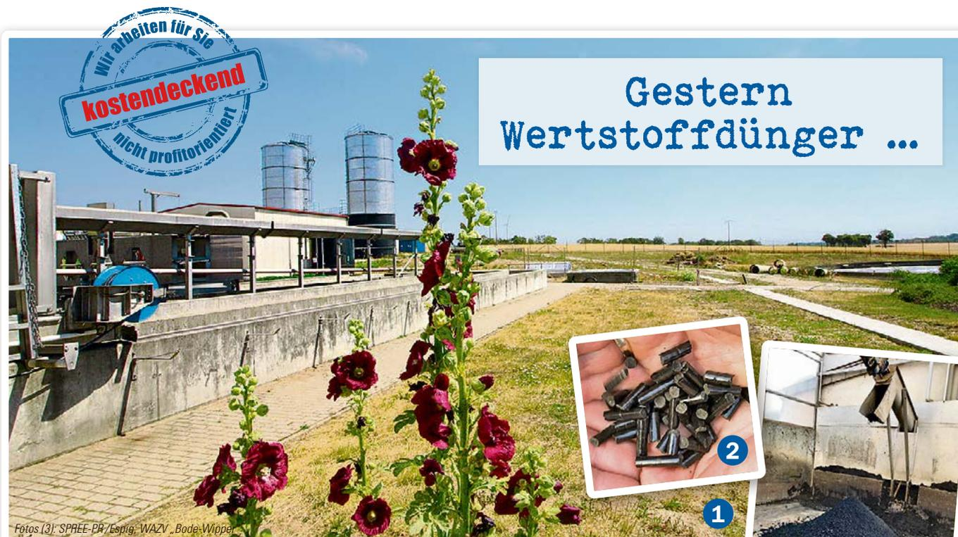
1 Die neue Verbandskläranlage. 2 Klärschlamm zu staubtrockenen Pellets gepresst. 3 Durch Hitze wird Flüssigkeit aus Klärschlamm gezogen.
