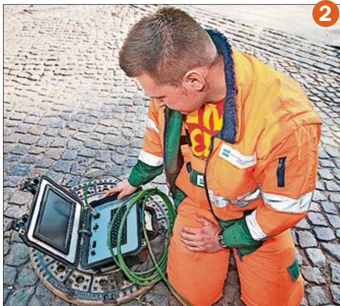
Ein abwechslungsreicher Tag im Leben der Abwasserfachkräfte: Sebastian Wessel zeigt die Kamera, die einen hochauflösenden Blick in den Kanal ermöglicht (1). Stefan Jedlitschka inspiziert den soeben gereinigten Kanal am Monitor (2), um schon kurze Zeit später mit dem Saugwagen des WAZV eine abflusslose Sammelgrube auszupumpen (3). Währenddessen tauschen Dominic Radl (1.) und Marcus Bullin die beschädigte Pumpe eines unterirdischen Pumpwerks aus (4).
