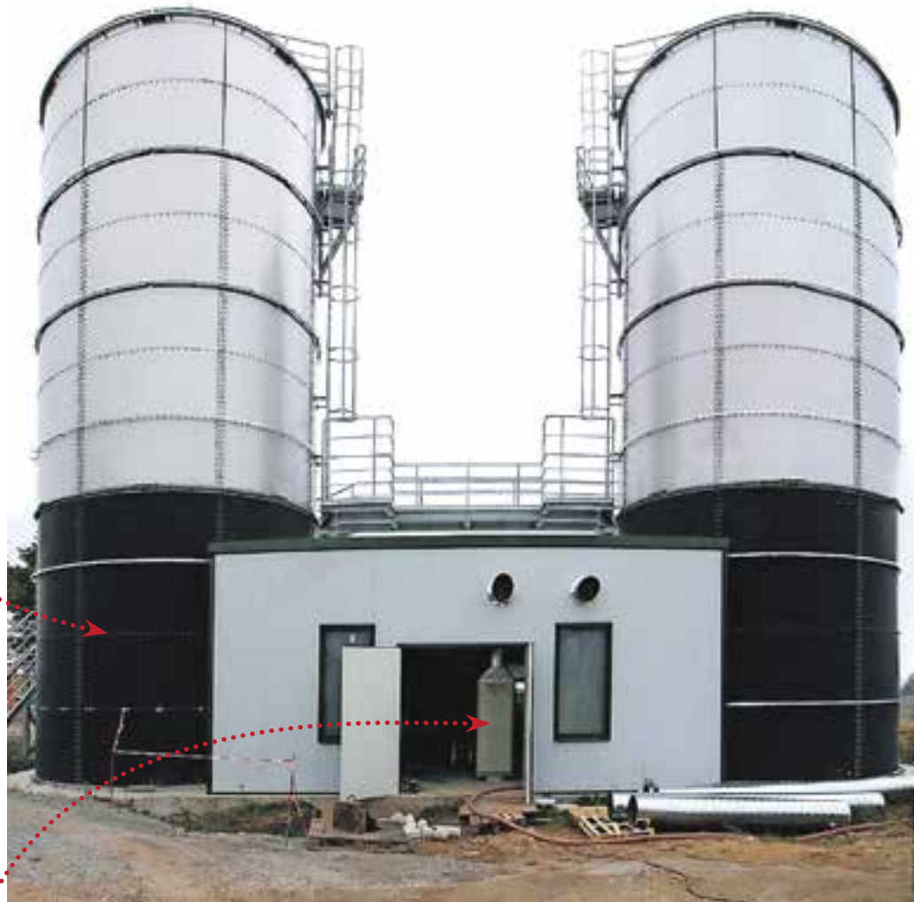
Chromglänzend stehen die Türme des neuen Faulturmkomplexes auf der Verbandskläranlage in Staßfurt.
