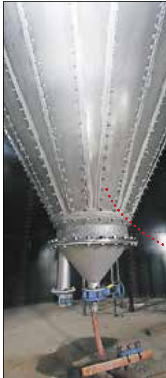
Blick ins Innere des Faulturmes: Dieser Trichter ist nur eines von vielen Puzzleteilen im Gesamtkonzept.
