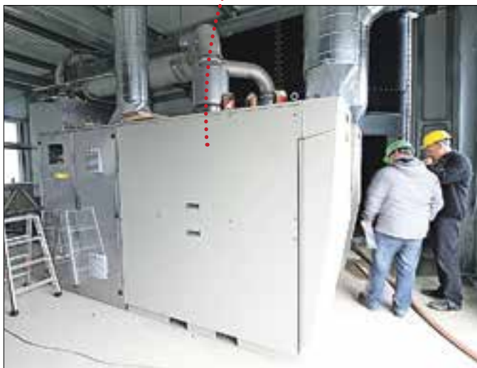
Die Gasturbinen befinden sich in diesem unscheinbaren Schrank. Erstaunlich, dass im Inneren eine Turbine mit rund 100.000 Umdrehungen pro Minuten laufen wird.
