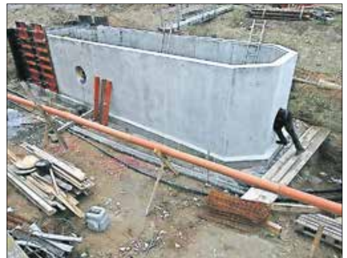
Hier entsteht eine Primärschlammabscheidung, in deren Innerem feine Siebe eingebaut werden. Der aus dem Abwasser gefilterte Schlamm wird anschließend in den Faulturmkomplex geleitet.
