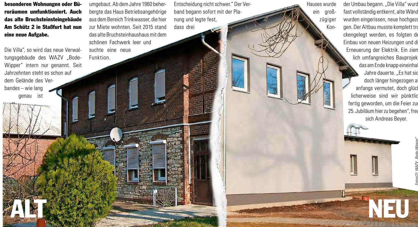
Früher diente das alte Bruchsteinengebäude auf dem Gelände des WAZV als Wohnhaus.
