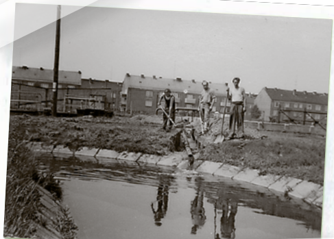
ca. 1967: Abwasserreinigung am Oxidationsgraben in Güsten.
