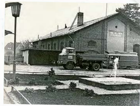
1973: neuer Verbandssitz, Am Schütz 2 (Standort Industriewasserwerk) dient bis heute als Verbandssitz und Meisterbereich Trinkwasser.
