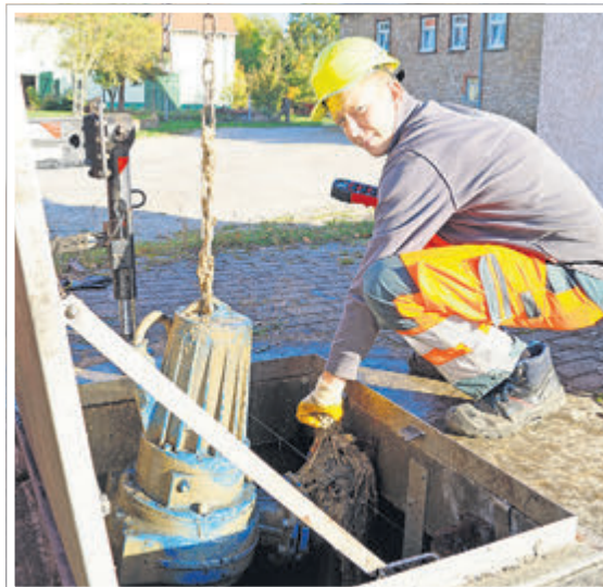
... bevor der „Zopf“ aus Toilettenabfällen von Hand beseitigt wird.
