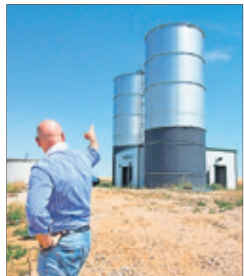
Bauherr Andreas Beyer überwacht den Fortschritt auf der größten Baustelle des Verbandes.
