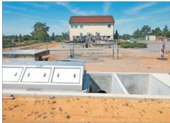
Die Primärschlammableitung ist so gut wie fertig. In ihrem Inneren befinden sich feine Siebe, die den Schlamm aus dem Abwasser filtern.
