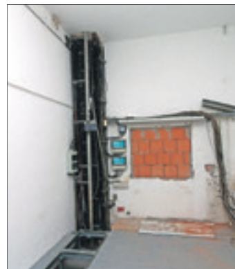
Die komplizierte Verkabelung der Technik nimmt die meiste Zeit in Anspruch.
