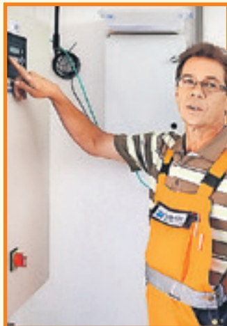
Ulrich Jecht prüft die Pumpenanlage der Druckerhöhungsstation in Kroppenstedt.
