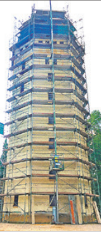
Macht sich hübsch für seinen einhundertsten Geburtstag im September: der Wasserturm Egel wird momentan durch den WAZV saniert.
