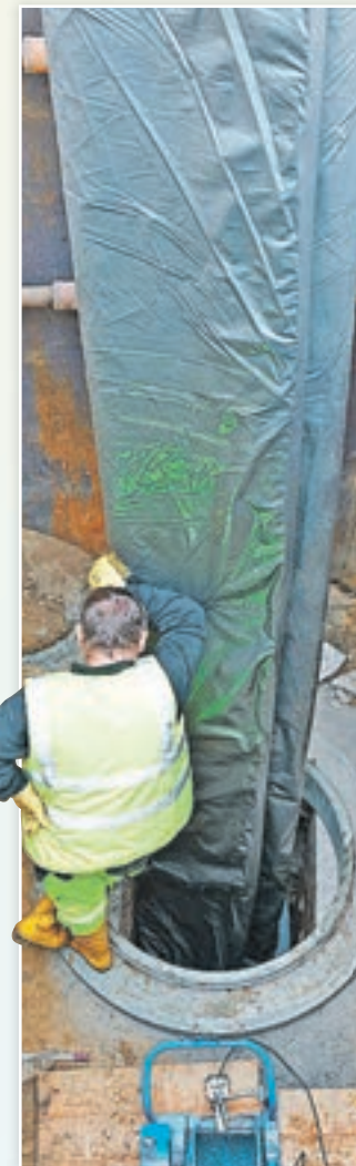
Baustelle Wasserkunststraße in Staßfurt, ein Schlauchliner wird eingesetzt. Dabei bleiben alte Kanäle im Boden, die neuen werden einfach in sie eingeführt. Das spart jede Menge Geld.
