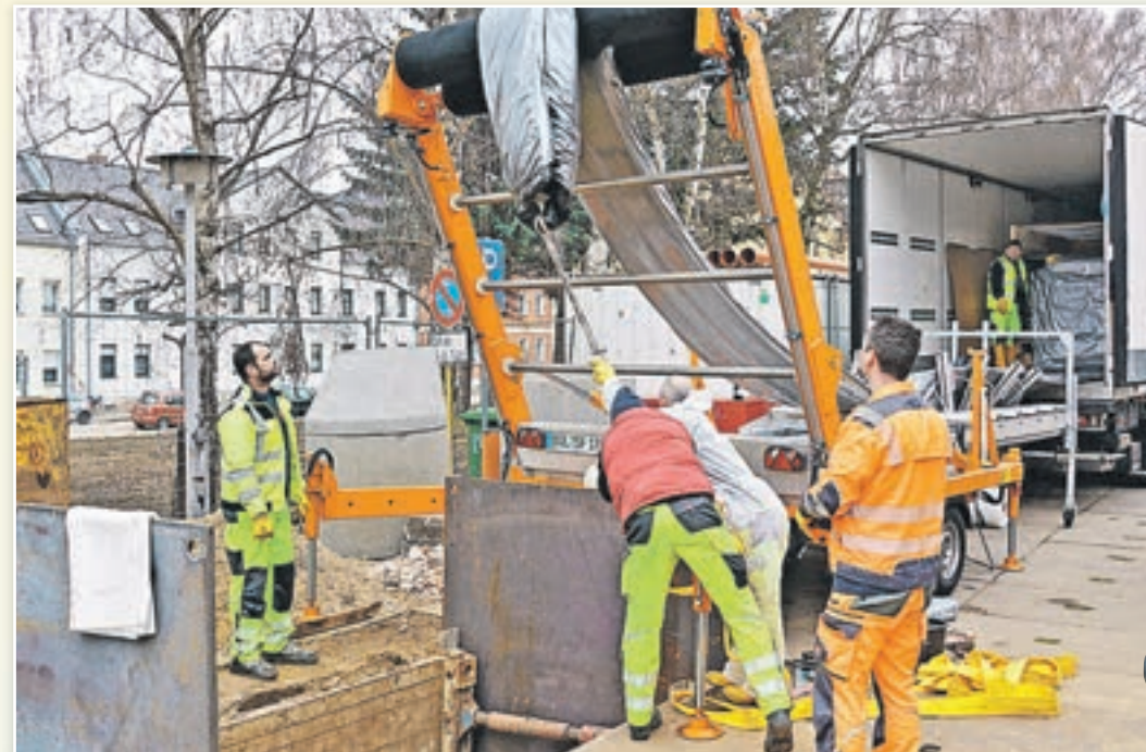
Baustelle Wasserkunststraße in Staßfurt, ein Schlauchliner wird eingesetzt. Dabei bleiben alte Kanäle im Boden, die neuen werden einfach in sie eingeführt. Das spart jede Menge Geld.
