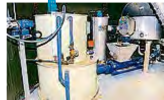
Dosierstation und Scheibeneindicker zur Vorbehandlung des Abwassers.
