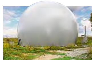
Der Gasspeicher hat einen Durchmesser von 13 m.
