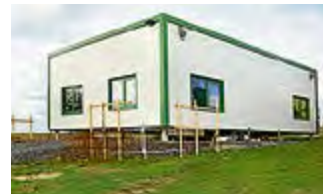
Das neue Verwaltungsgebäude im Rohbauzustand.
