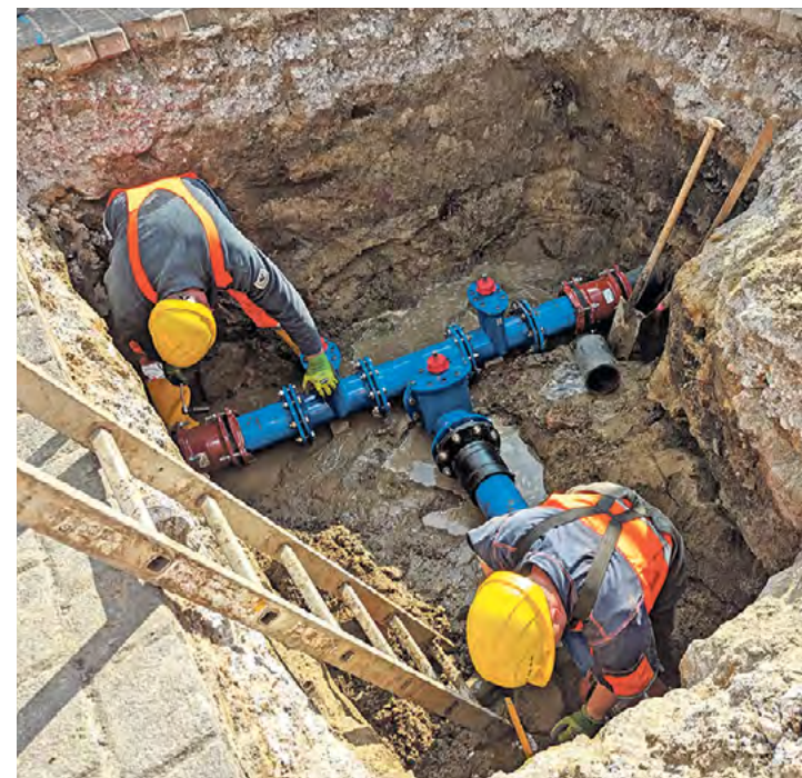
Für ein stabiles Trinkwassernetz müssen aufwändige Baumaßnahmen gut geplant sein. In Zeiten von explodierenden Material- und Bauleistungspreisen ein Balanceakt.
