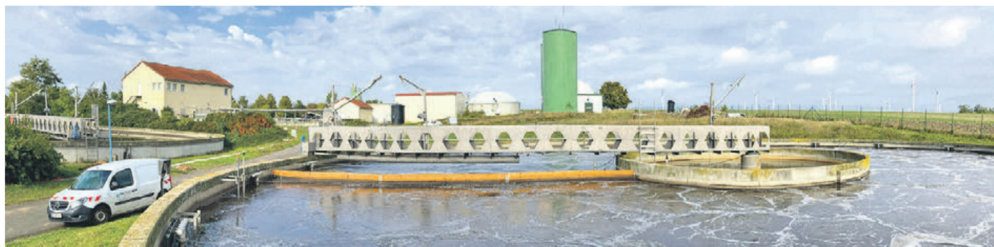
Aufwändiger Umbau der Belebungsbecken: Mit einer neuen Verfahrensweise soll langfristig Energie und damit Kosten gespart werden. Fotos (2): SPREE-PR/Wolf
