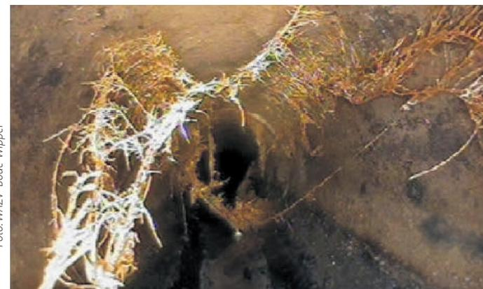
Was ist denn da im Rohr? Wurzeln, die eingewachsen sind, müssen entfernt werden, sonst drohen Verstopfungen.
