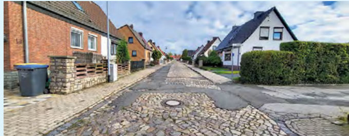
Ein Ort von vielen: Hier im Staßfurter Knappenweg wird die Trinkwasserleitung erneuert. Foto: WAZV „Bode-Wipper“
