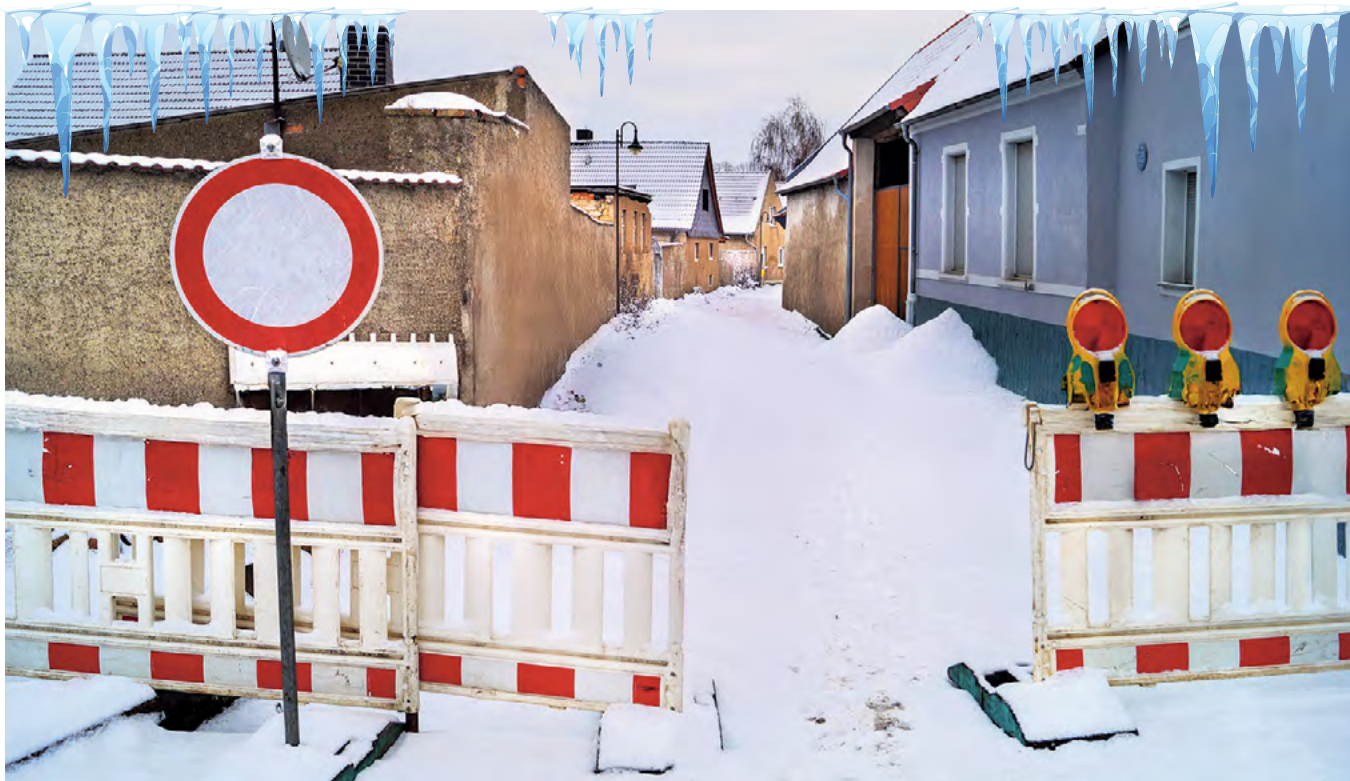
So wie hier in der Oststraße in Schneidlingen ruhten im Winter im Verbandsgebiet die Arbeiten am Trinkwassernetz. Doch schon bald gehen die Maßnahmen des WAZV weiter. Der Verband hat auch in diesem Jahr viel vor.
