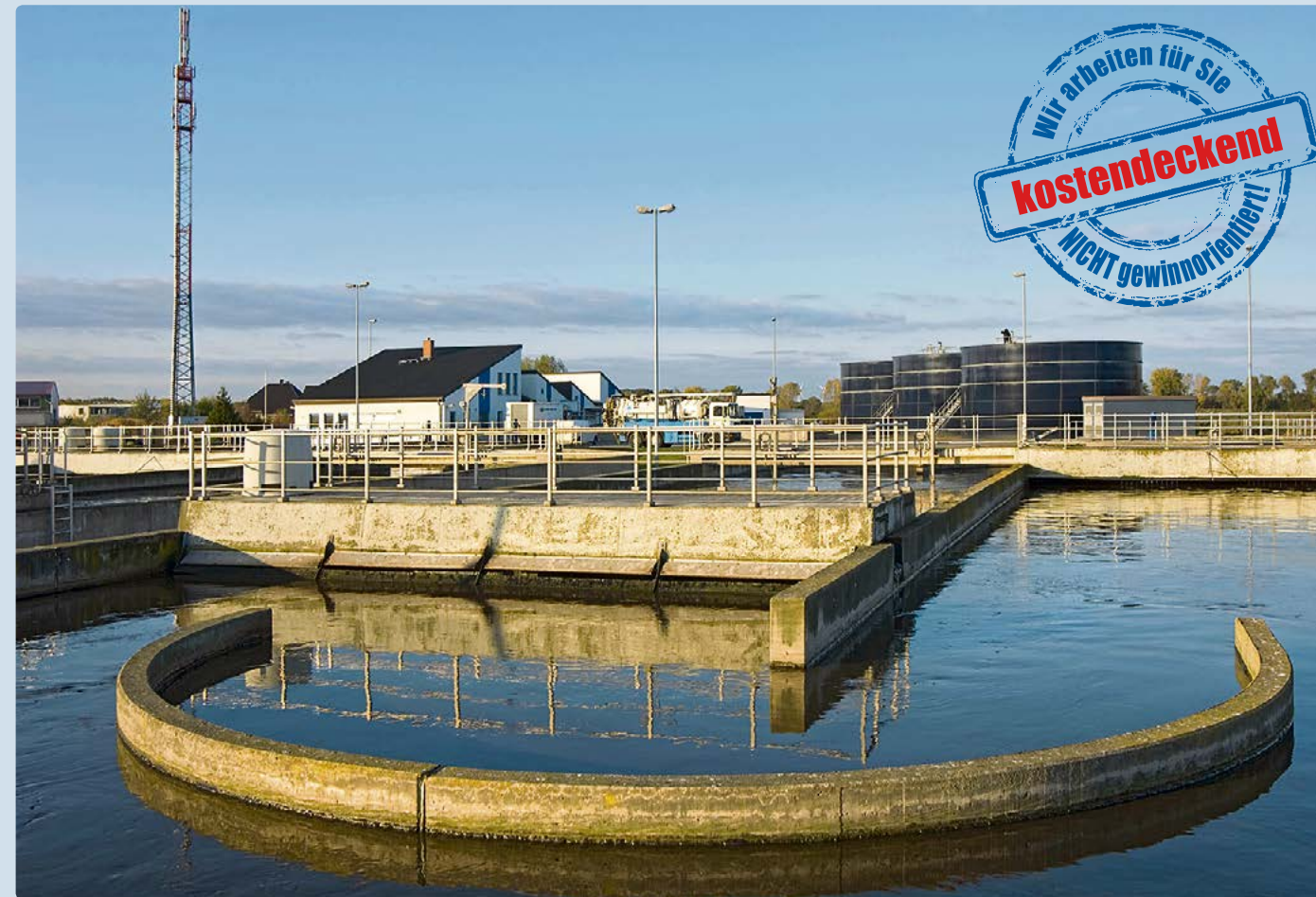
Einer der größten Kostenfresser ist die Kläranlage in Hecklingen. Denn nicht nur Schmutz- sondern auch Niederschlagswasser kommen dort zur Weiterbehandlung an.
