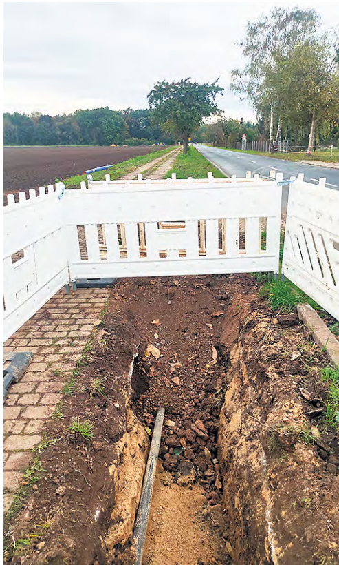
Auf einer Länge von über 750 Metern wurde die Ortszuführungsleitung bis nach Rathmannsdorf erneuert.
