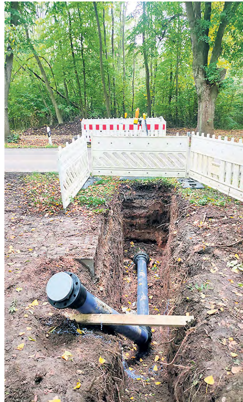
Um vorhandene Leitungen nicht zu beschädigen, wurde die Straße an mehreren Stellen unterquert.
