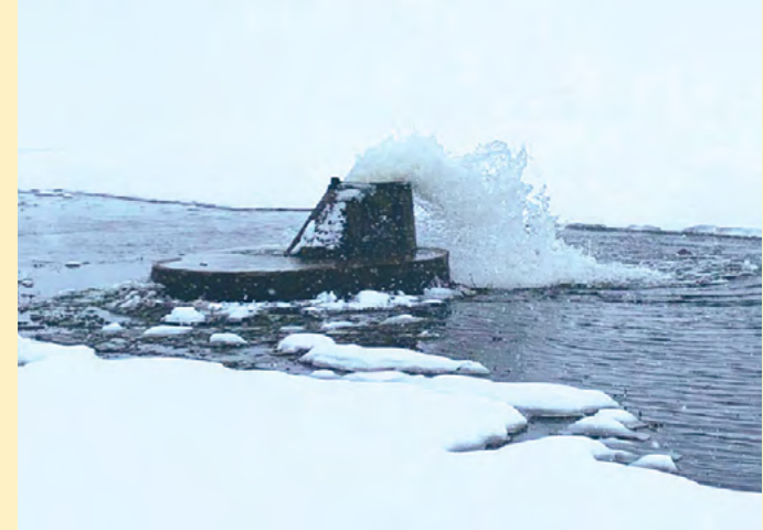
Hier ist keine Flusslandschaft zu sehen, sondern die verheerenden Folgen eines Rohrbruchs aus diesem Winter. Foto: WAZV Bode-Wipper
