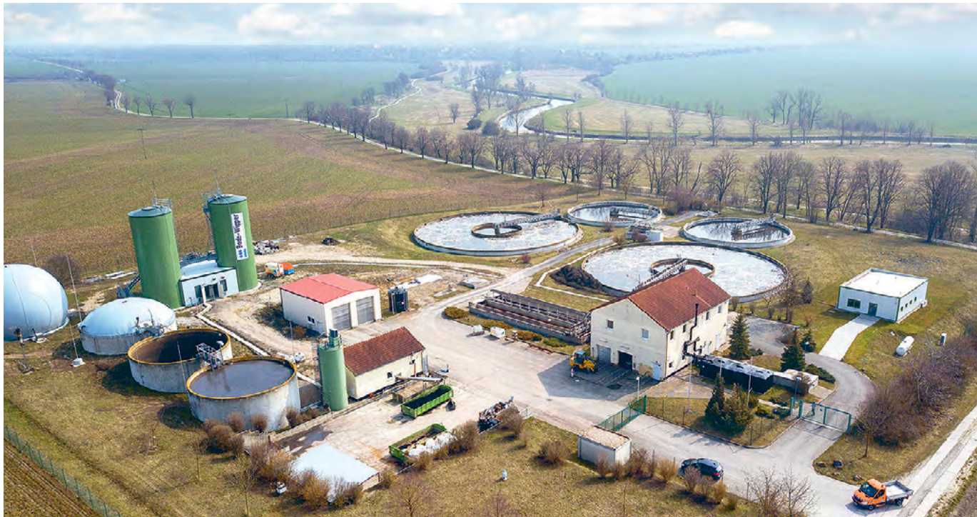
So sieht die Verbandkläranlage des WAZV also aus der Vogelperspektive aus. Die beiden grünen Faultürme, die herausragen, sind künftig maßgeblich für die Energieversorgung der Anlage zuständig.
