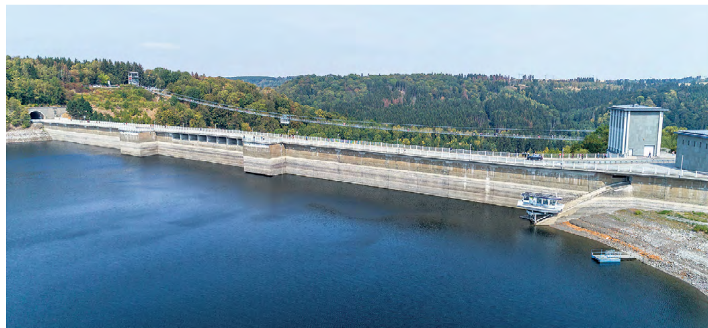
Die Rappbodetsperre (im Bild), die Zillierbachtalsperre und der Teufelsteich haben in den letzten 20 Jahren im Schnitt 45,98 Mio. m 3 Rohwasser pro Jahr bereitgestellt – 37% des Gesamtverbrauchs in unserem Bundesland.
