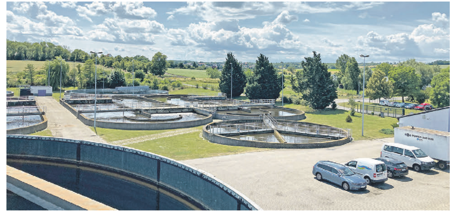
Die Kläranlage Hecklingen, die das Abwasser von bis zu 40.000 Einwohnern reinigen kann, soll demnächst energetisch ertüchtigt werden. Fotos (4): SPREE-PR/Wolf
