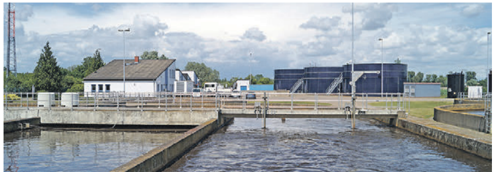
Die Kläranlage Hecklingen ist das Herzstück des Abwasser Gebiet II. Rund 1,75 Millionen Kubikmeter Schmutz- und Niederschlagswasser werden hier jährlich gereinigt.
