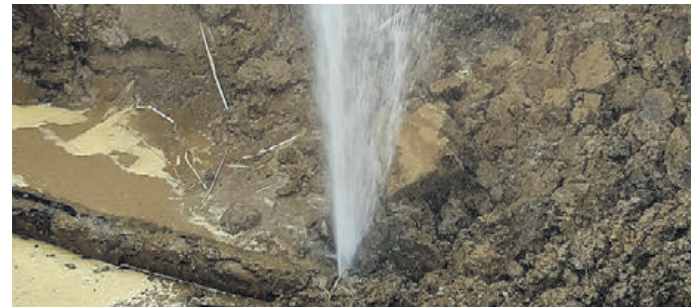
Undichte Leitungen aufspüren: Der Verband setzt seit Jahren erfolgreich ein Sanierungskonzept um. Foto: SPREE-PR/Archiv
