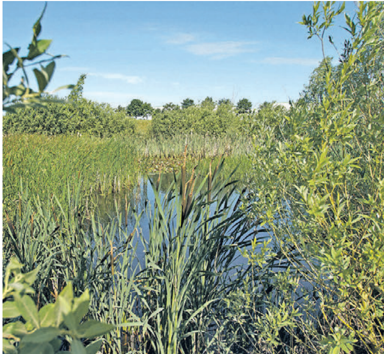
Das Regenrückhaltebecken in Egel – eine wasserwirtschaftliche Anlage, auch, wenn sie wie ein Kleinod aussieht.
